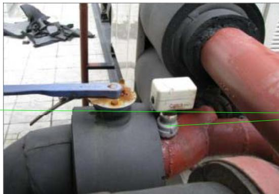
Реле протока не может быть установлено в месте поворота трубопровода гидравлических коммуникаций
